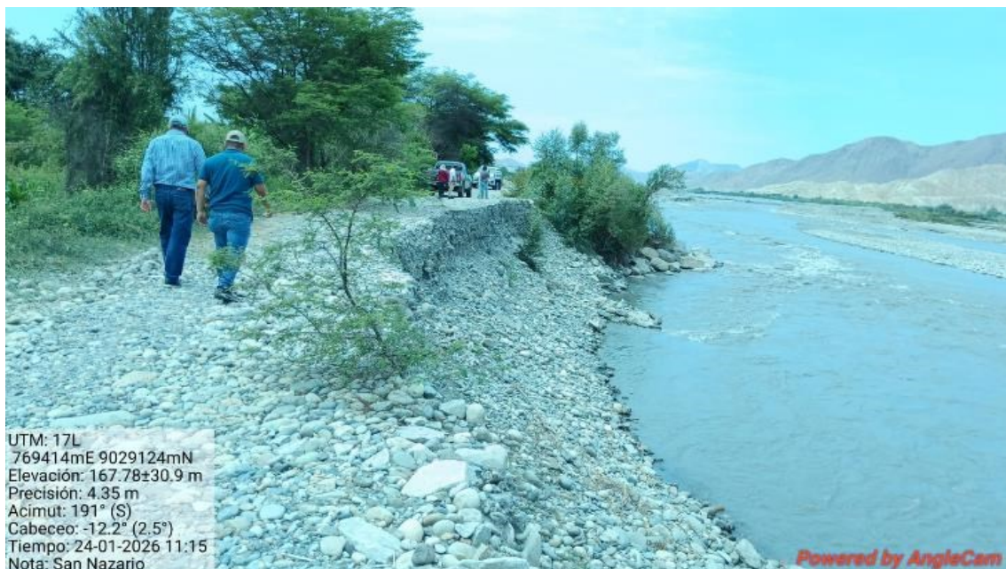
FIGURA N°02: SE APRECIA QUE LA DEFENSA EXISTENTE EN LA MARGEN IZQUIERDA DEL RIO SANTA SE ENCUENTRA DAÑADA, EROSIONADA, CON TENDENCIA A SER DESLIZADO POR EL AUMENTO DEL VOLUMEN Y AFECTAR AREAS AGRICOLAS E INFRAESTRUCTURAS HIDRAULICAS ALEDAÑAS A ESTA.
