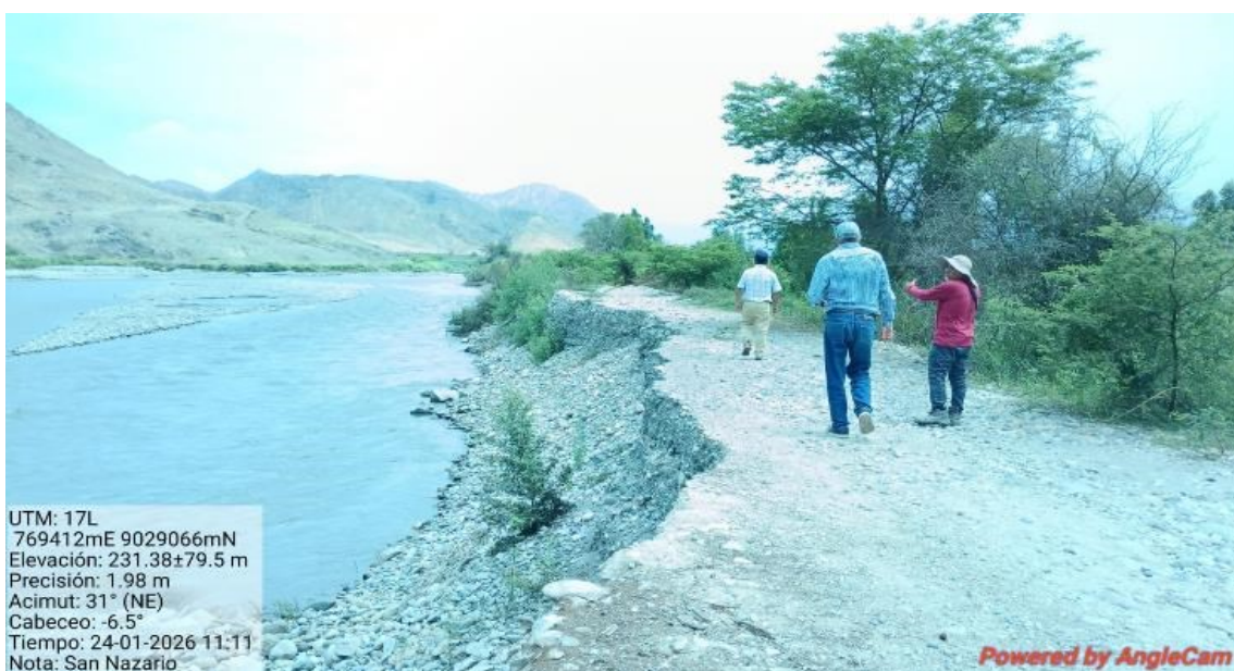
FIGURA N°03: TRAMO DEL RIO DE 110 m QUE NO TIENE PROTECCION EN LA MARGEN IZQUIERDA DEL RIO, POR TANTO PUEDE AFECTAR A AREAS AGRICOLAS, POBLACION E INFRAESTRUCTURAS HIDRAULICAS ALEDAÑAS A ESTA.
