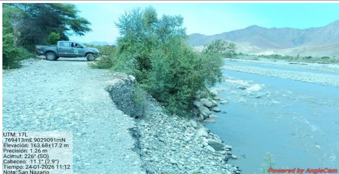
FIGURA N°01: TRAMO CRÍTICO EN EL RÍO SANTA, NO HAY PROTECCION EN LA MARGEN IZQUIERDA, SE PLANTEA LA PROTECCION CON DIQUE ENROCADO EN UNA LONGITUD DE 110 ml, COLOCACION EN UN PUNTO (01) UN ESPIGON; EN EL SECTOR SAN NAZARIO- VINZOS, DISTRITO DE CHIMBOTE, PROVINCIA DE SANTA - ANCASH.
